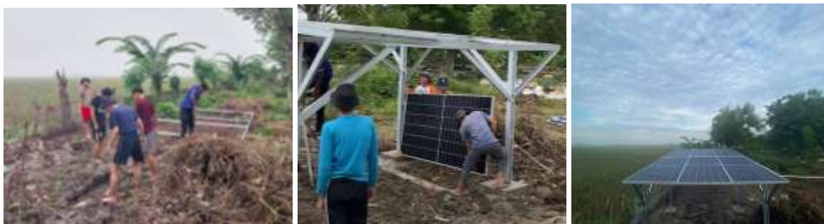
Gambar 7. Proses Perakitan Panel Surya di TPU Desa Tanjung Karawang oleh DEB Sobat Bumi Karawang
