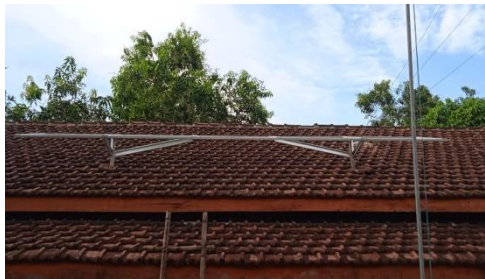
Gambar 4. Rangka Galvalum Setelah Terpasang Di Atap
