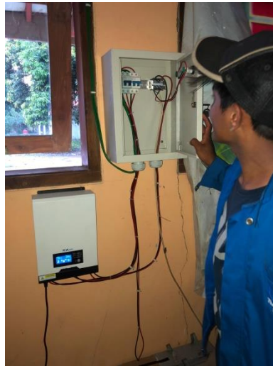
Gambar 6. Pemasangan Inverter dan Panel Box
