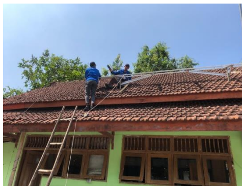
Gambar 5. Pemasangan Panel PV Di Atap Sekolah
