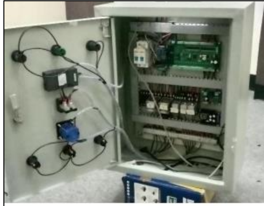
Gambar 5. Tampilan Dalam Panel ATS
