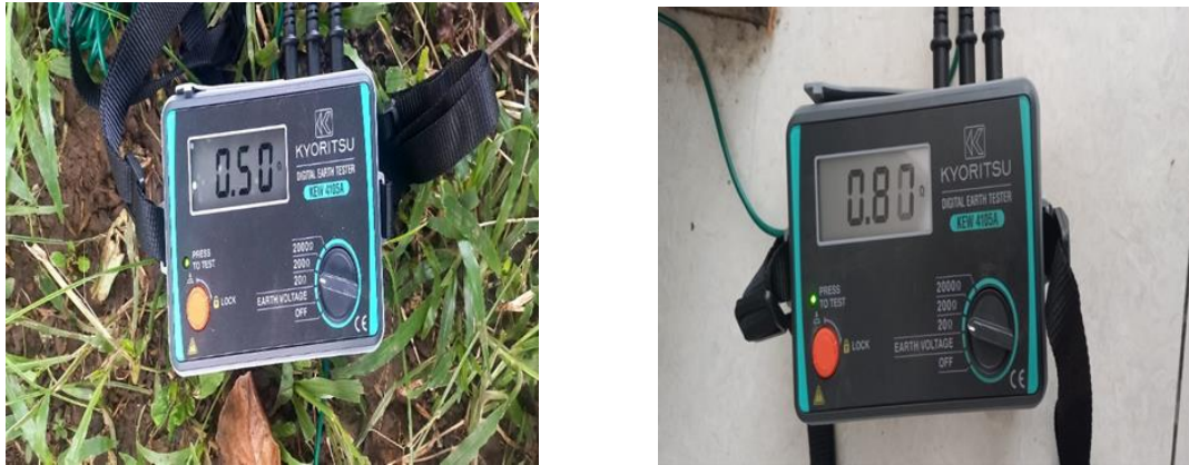
Gambar 5 Pengukuran: Gedung A (kiri) dan Gedung D (kanan)
